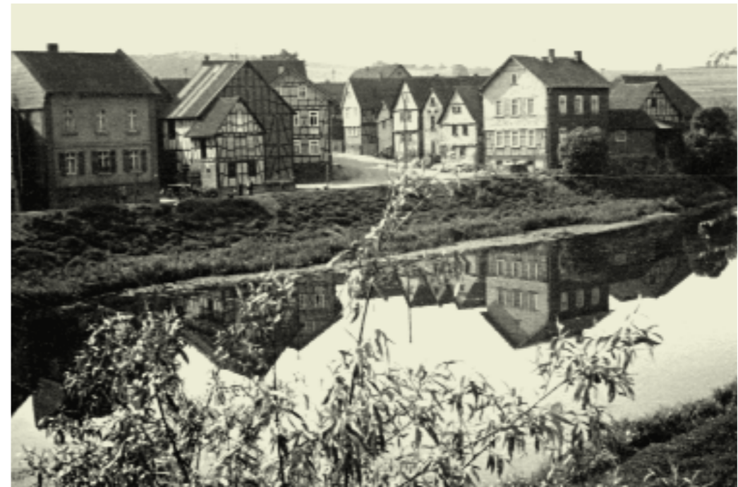
Blick auf die Obergasse
