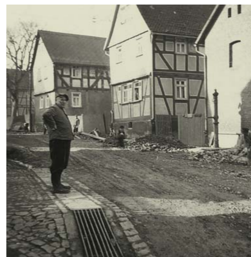
Kanalbau in der Obergasse
